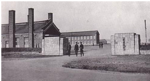
图4 伪满洲国“建国大学”校舍旧影
